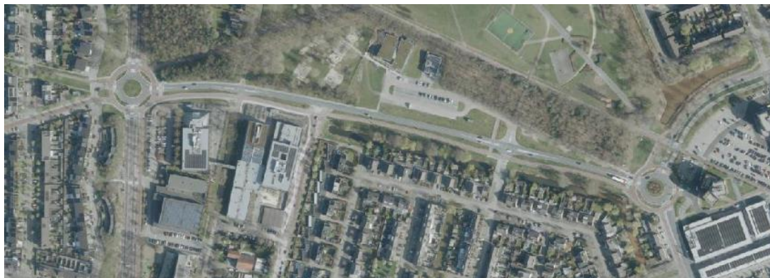
Afbeelding 1: Overzichtsfoto rotondes na reconstructie.
